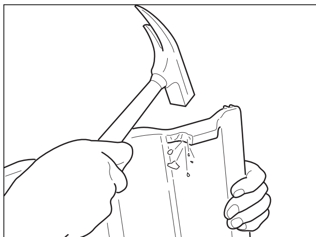
3.34. ábra Ha a tetőcserepek felfekszenek az oldallemezre, akkor szükség esetén üssön le egy beakasztó bütyköt, fúrja keresztül a cserepet, majd fixen csavarozza rá a lécre (ne a lemezre).
