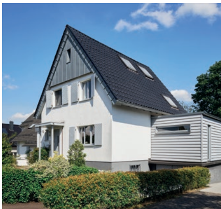
Meglévő épületben ideális a földgázüzemű hőtermelő kiváltására
