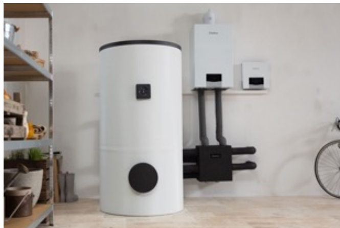
Hibridrendszer kondenzációs ecoTEC gázkészülékkel, hőszivattyú-szabályozómodullal és melegvíz-tárolóval
