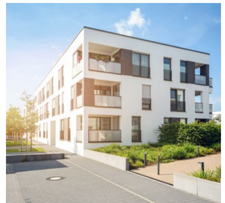
Szükség esetén kaszkárendszer is kialakítható a többlakásos lakóépületekben történő telepítésnél
